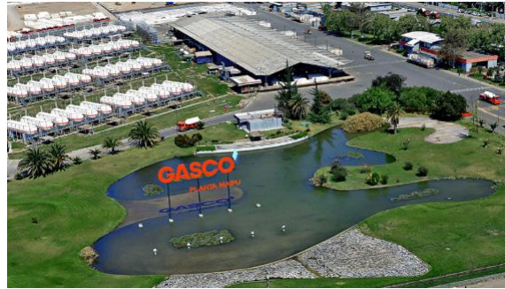
Ilustración N° 1,1 GASCO GLP S.A Planta Maipú
