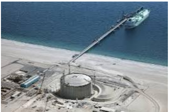
Terminal de Mejillones, embarcadero de regasificación y tanque de almacenamiento.
