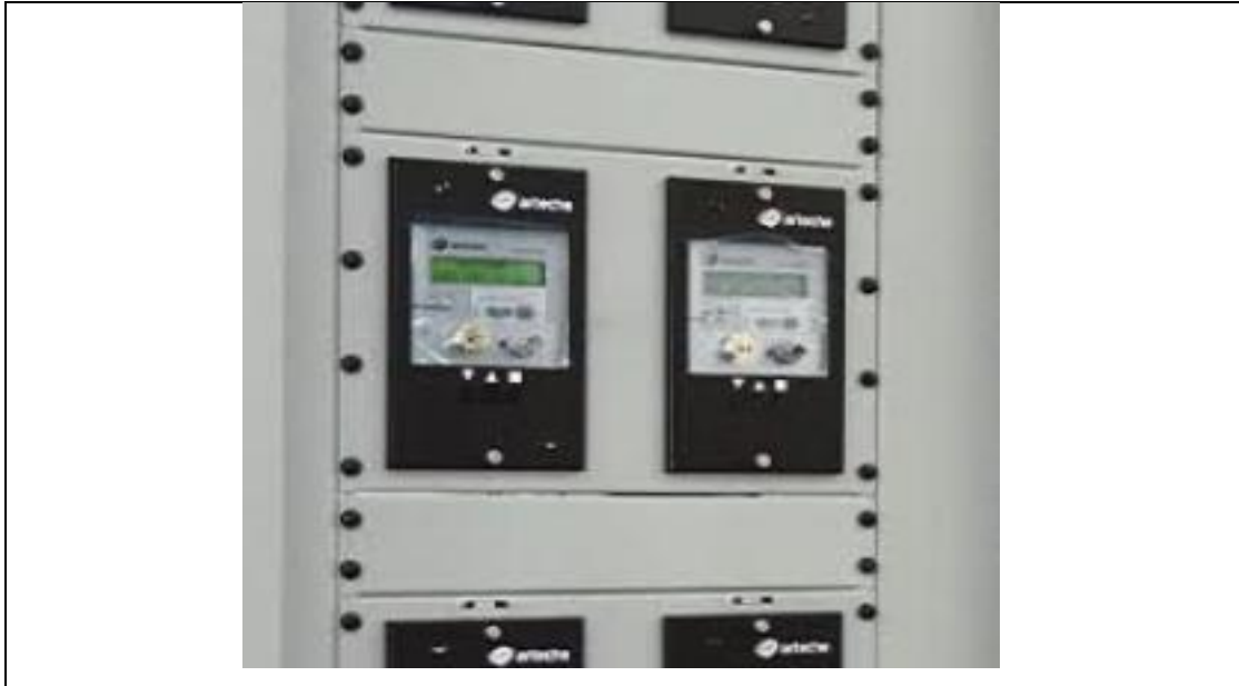
Figura 14: Medidor de Facturación ION
