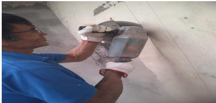
Fotografía 1: Albañil realiza trabajos de cortes.
