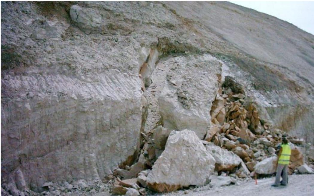
Fig. 2.4.2.4 Fotografía rotura en cuña
