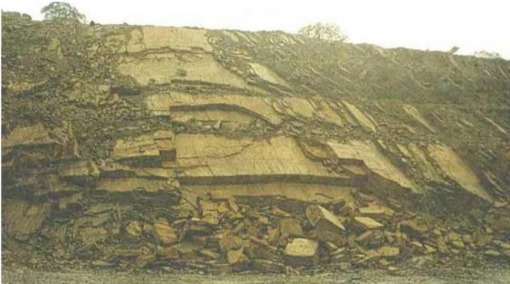
Fig. 2.4.2.2 Fotografía Rotura plana
