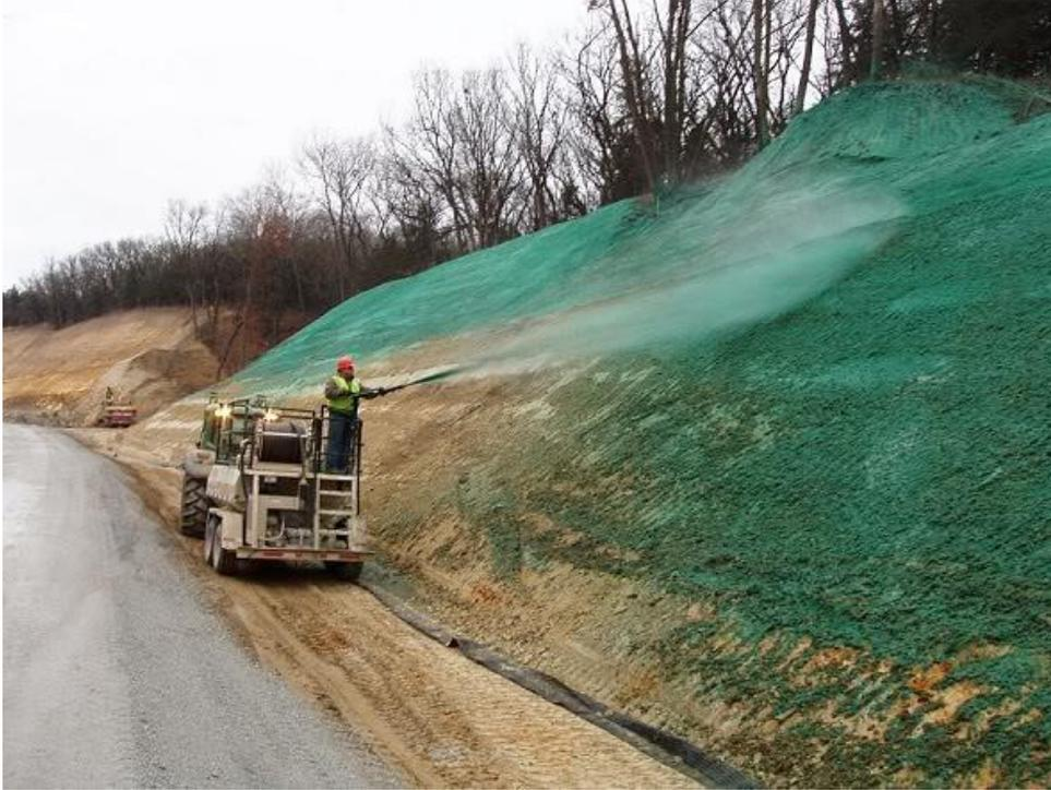
Fig. 4.2.5.2 Hidrosiembra en talud
