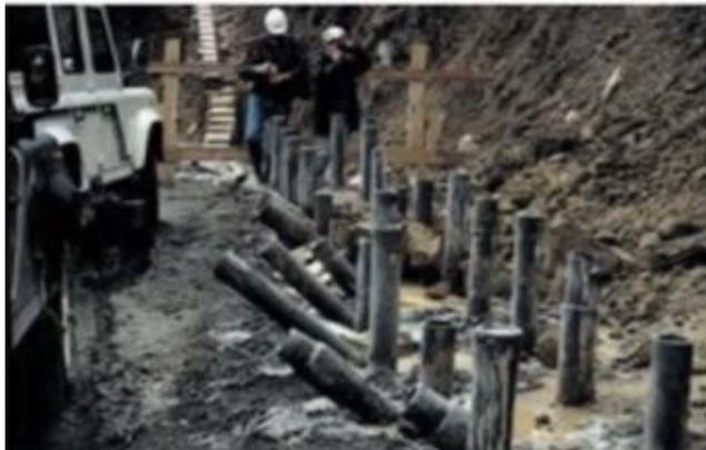
Fig. 4.2.3.1 Pilotes reforzando un talud
