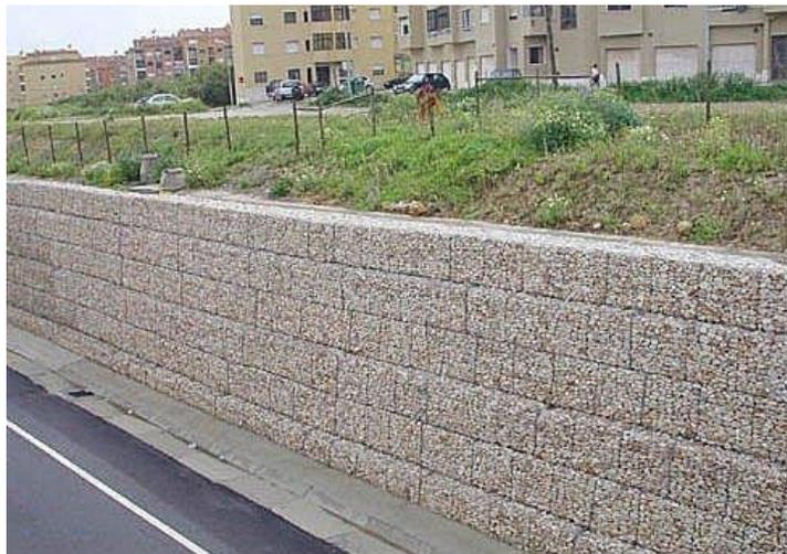
Fig. 4.2.4.2 Muro de gaviones para sostener talud
