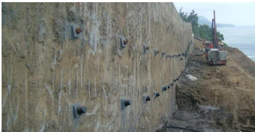
Fig. 4.2.3.2 Talud con instalación de pernos de anclaje
