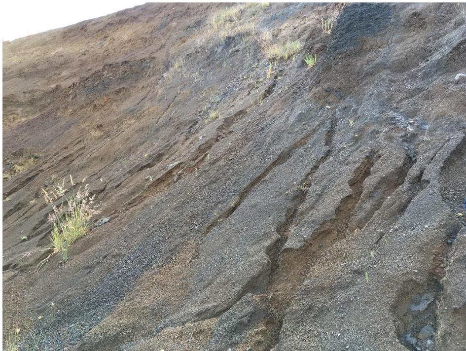
Fig. 10.6 Fotografía muestra erosión del talud (efecto de lluvia y viento)
