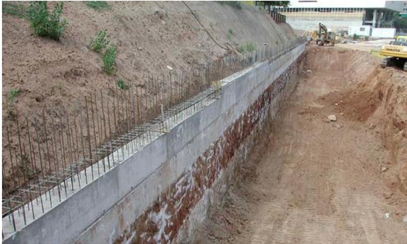
Fig. 4.2.4.1 Muro contenedor de talud
