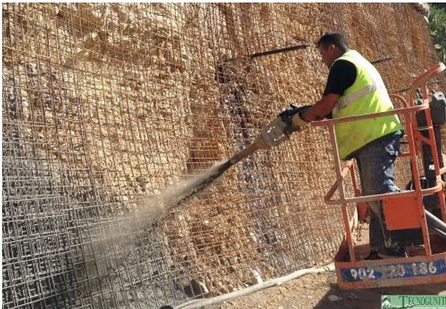
Fig. 4.2.5.1 Proyección de cemento sobre talud
