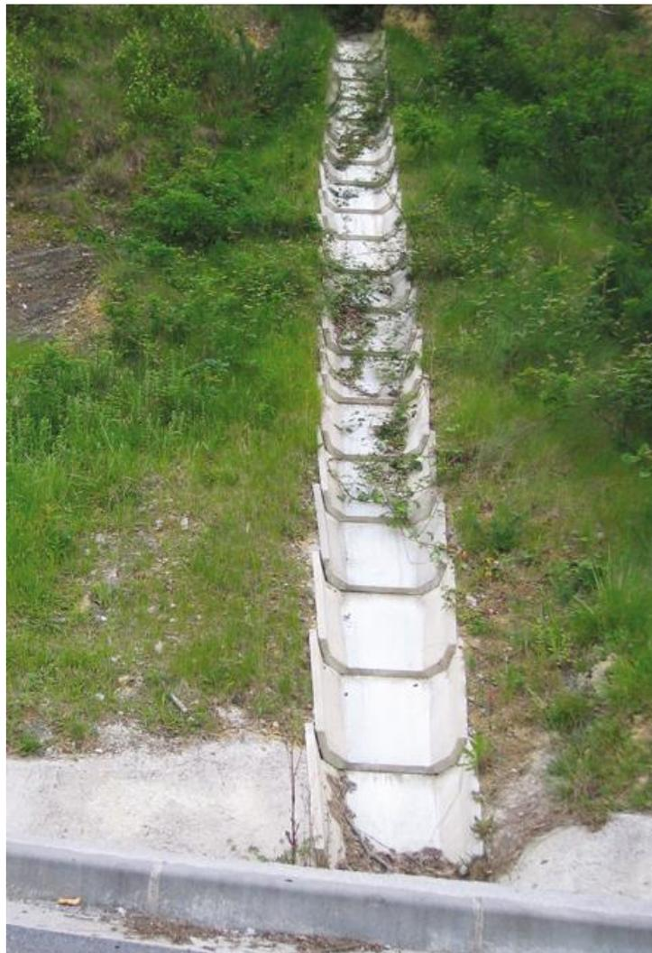
Fig. 4.2.2.2 Canal de bajada de aguas en talud
