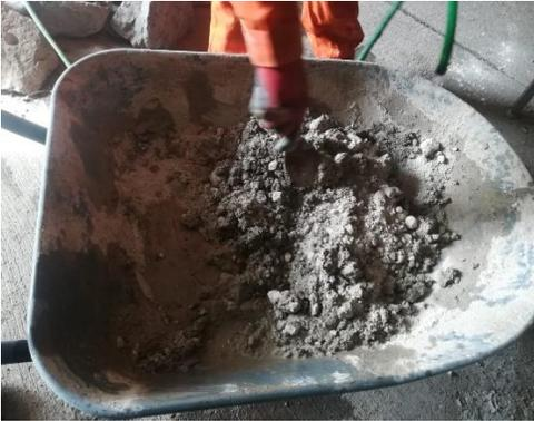
Lo primero es obtener el relave acondicionado el cual se utiliza en húmedo, para posteriormente mezclarlo con las proporciones de cemento y cal de la siguiente manera:
