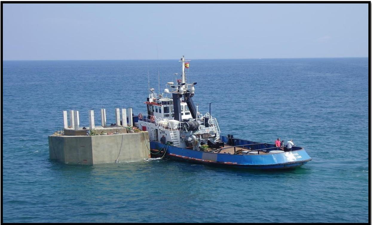
Figura 4.10. Torre de Captación (Fuente: sistemas-captación-desaladoras-agua-mar)
