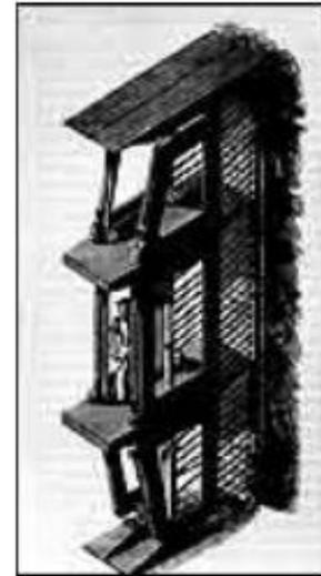
Fig. 4. A la izquierda una imagen de época del túnel construido bajo las aguas del río Támesis y a la derecha otra del escudo utilizado y patentado por Brunel para este mismo proyecto (1843)
