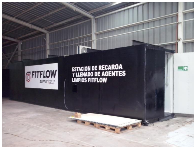
Figura 4.3 Estación de primer llenado de agentes limpios
