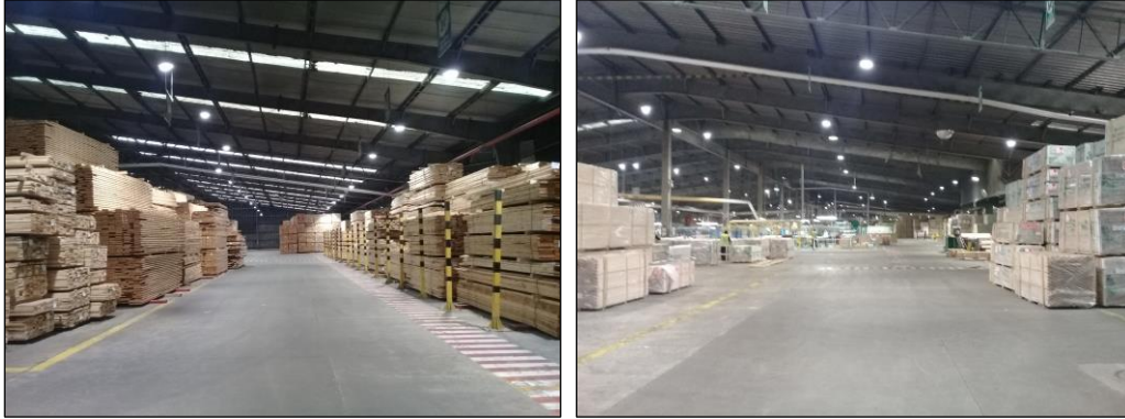
Figura 5.1 Implementación del proyecto en Planta Remanufactura Valdivia.
