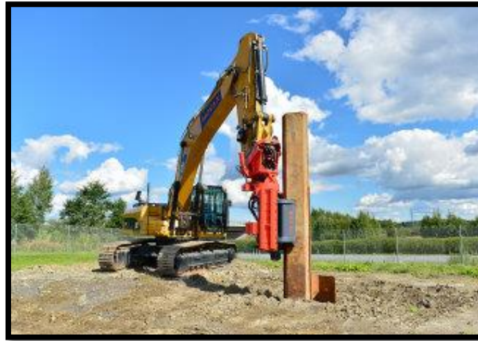
Ilustración 25: Vibro Movax montado en máquina excavadora Caterpillar
