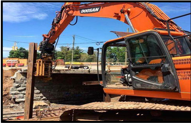
Ilustración 27: Vibro APE montado en máquina excavadora Doosan
