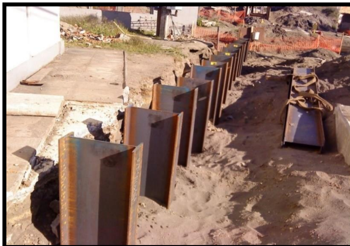
Ilustración 14: Hincado de perfiles obra Paso inferior Avenida Andalién Cliente Claro Vicuña Valenzuela
