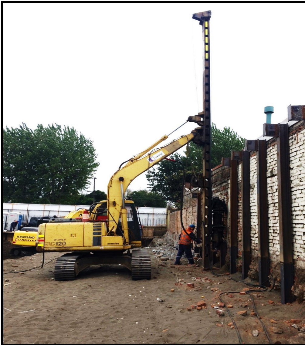
Ilustración 16: Actual sistema hincado Komatsu PC120 con martinete Grundoram Mini Gigant obra edificio Urban, Inmobiliaria Aitue
