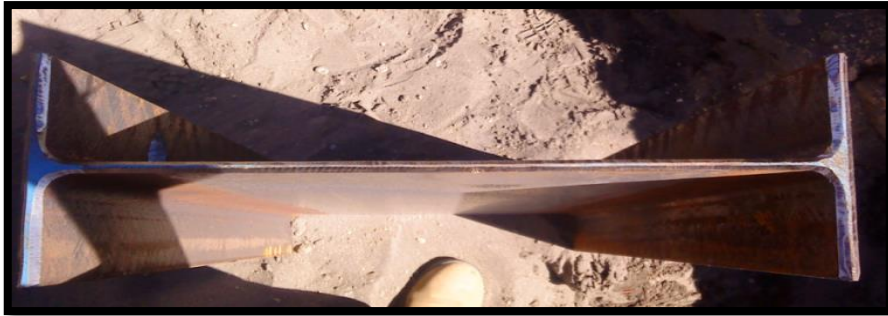
Ilustración 12: Biselado de perfiles WF410 x 46.1, apto para soldadura.
