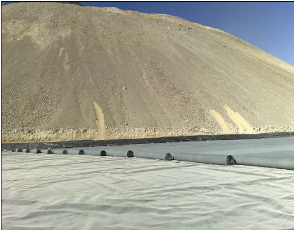
Figura 8, Liner o geomembrana, fuente Codelco
