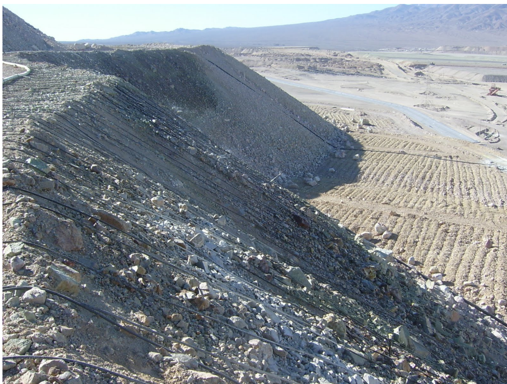
Figura 12, construcción de pilas, fuente Enami.
