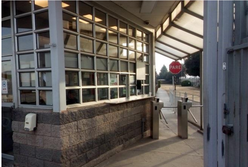
Foto 01: Acceso de Visita.
