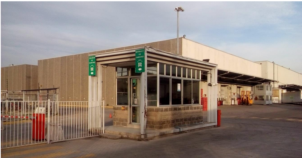
Imagen II-5 Acceso de Camiones
