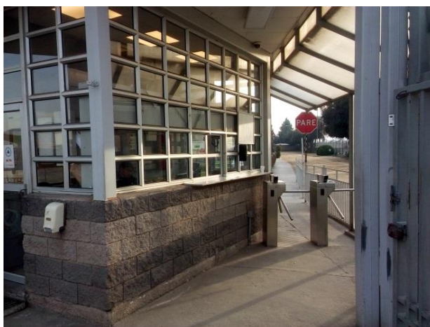
Imagen II-1 Acceso de Visita
