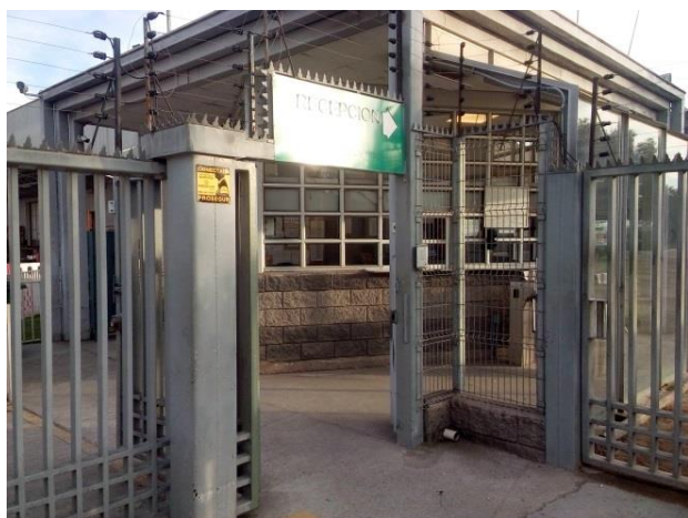
Imagen II-2 Acceso de Visita
