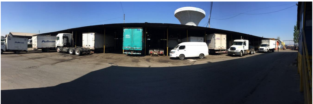
FIGURA N° 3 GALPÓN DE MANTENCIÓN, VISTA PANORÁMICA
