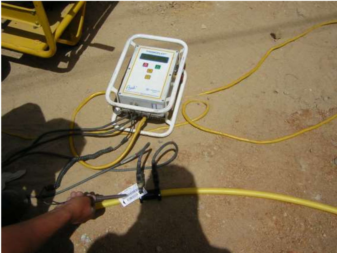
Figura N° 6.8: Detalle máquina Electro fusión.
