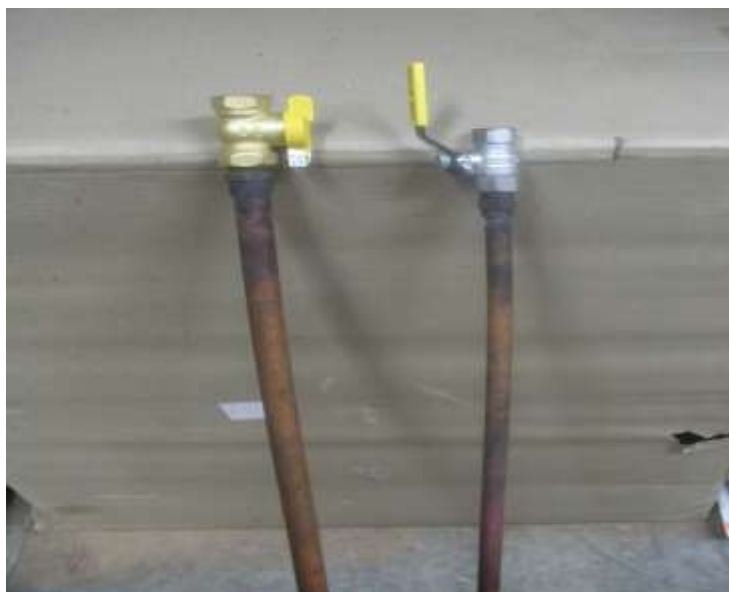
Figura N° 6.16: Reisser de cobre en ¾" y ½" con válvula de bola.
