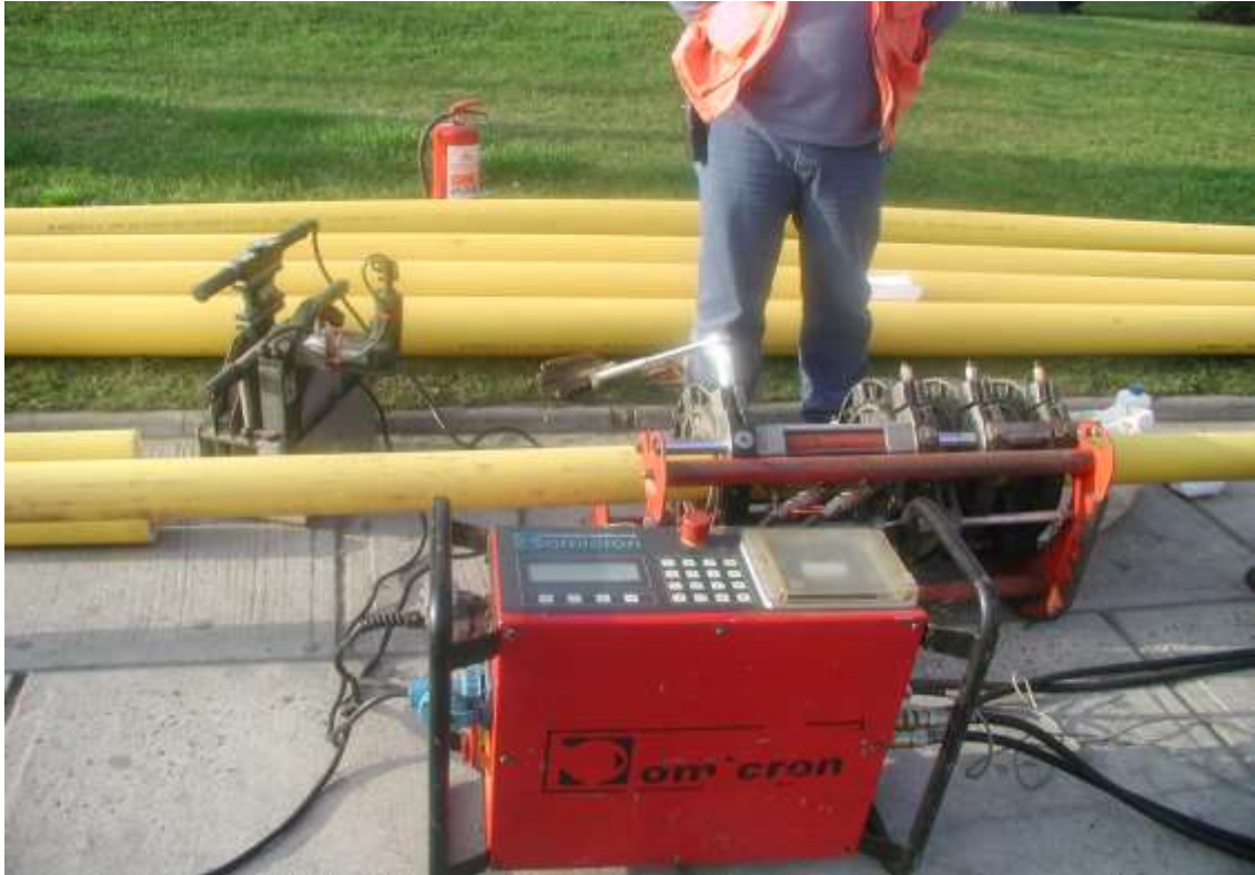
Figura N°6.5: Maquina automática de Termofusión hasta 250 mm.
