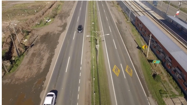
Imagen 2.3: Estación Alborada. Fuente: Ministerio de Obras Públicas.
