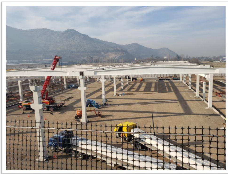
Ilustración 4 Inspección en terreno (Galpones de producción).
