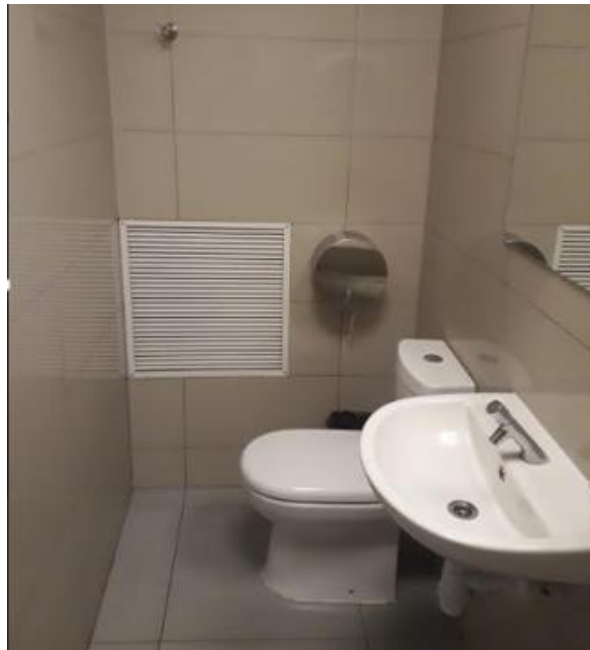
Foto 10: Baño actual ubicado en primer piso
