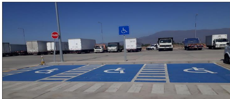
Foto 1: Estacionamiento de buenas dimensiones y circulación accesible, pero ubicados a una distancia de aprox. 100 mts. de acceso principal.
