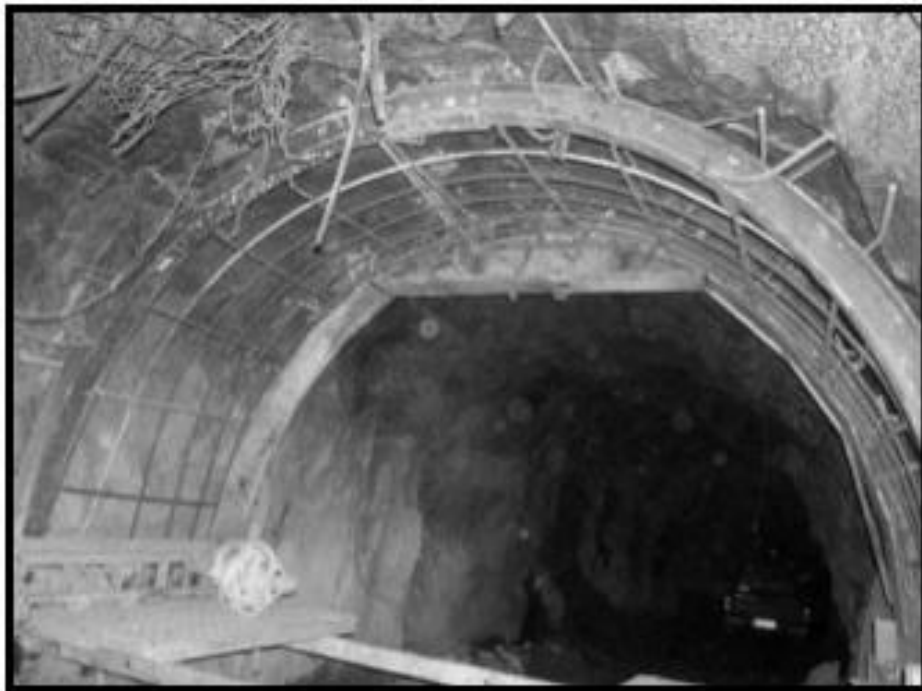
Figura 12: Arco Metálico Instalado
