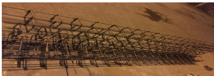
Figura N° 12: Fotografía de cadena de pilar
