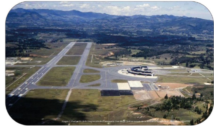
Imagen 2. Finalización de la construcción del aeropuerto José María Córdova km. 4 de la Bv. Occidental, Medellín, 2017-2018
