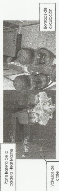
Figura 3.7 Vista de la parte trasera de la caldera Heat Master y las bombas de circulación
