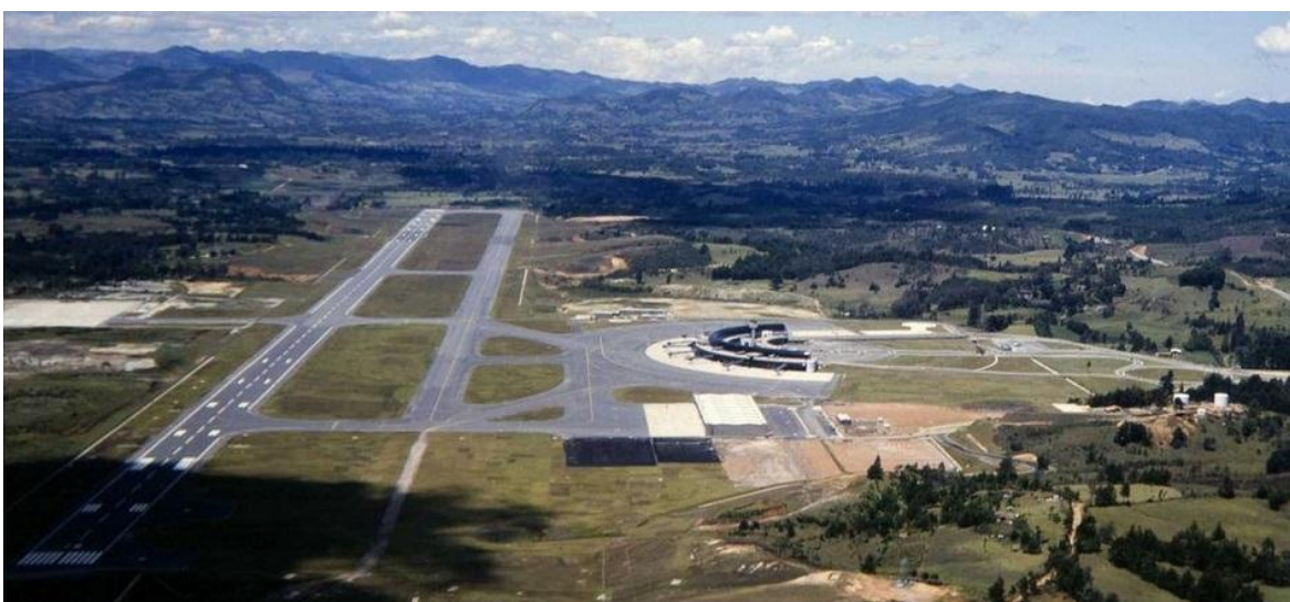
Figura 5.3. Finalización de la construcción de El aeropuerto José María Córdova
