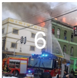
https://cooperativa.cl/noticias/pais/policial/incendios/incendio-afecto-a-edificio-patrimonial-en-el-centro-de-valparaiso/2017-04-24/181710.html Fotografía: @bomberosvalparaiso
