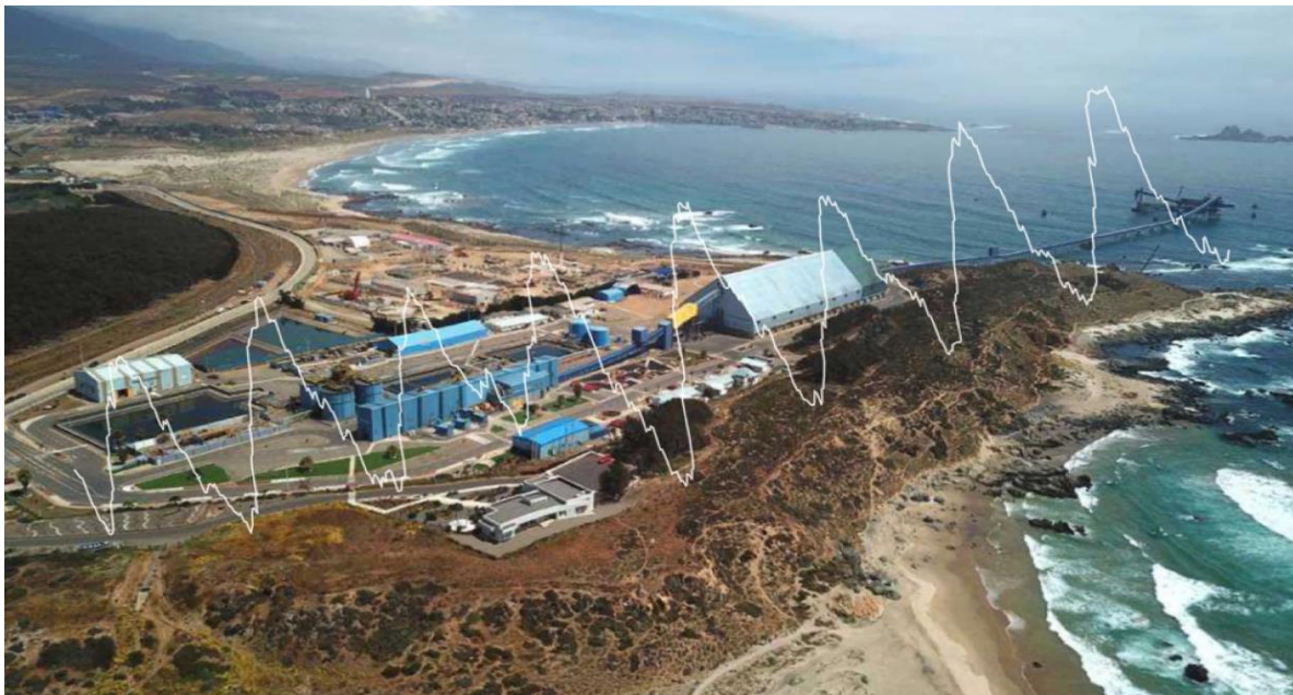
Figura 2.3: Ampliación planta desalinizadora de Minera Los Pelambres. Fuente: Reporte Sostenible, 2023; intervención gráfica: Elaboración propia, 2025.
